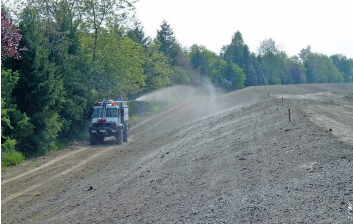
Anspritzbegrünung mittels Hydroseeder
