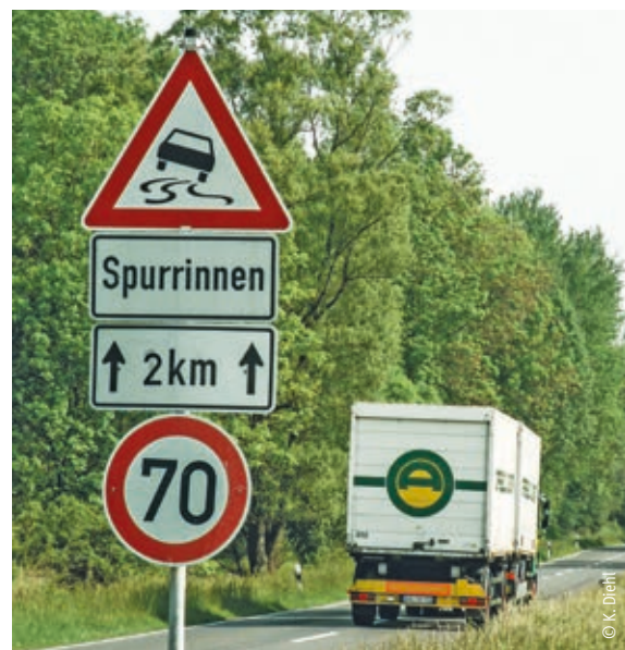
Ausbesserung mit Rapsasphalt im Kalteinbau
