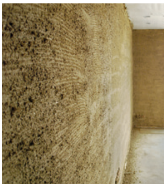
Ausbau mit Lehmsteinen und Lehmputz
