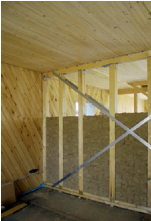
Ausbau mit Lehmsteinen und Lehmputz © Roswag & Jankowski Architekten
