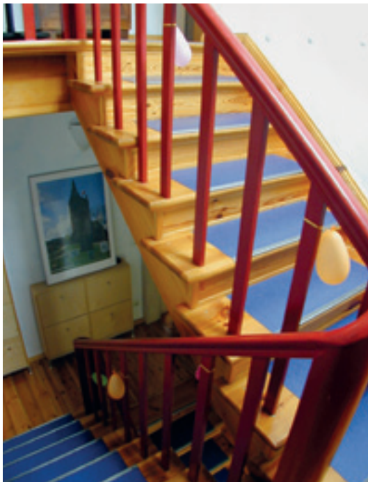
Linoleum als Treppenbelag © Klempnow
