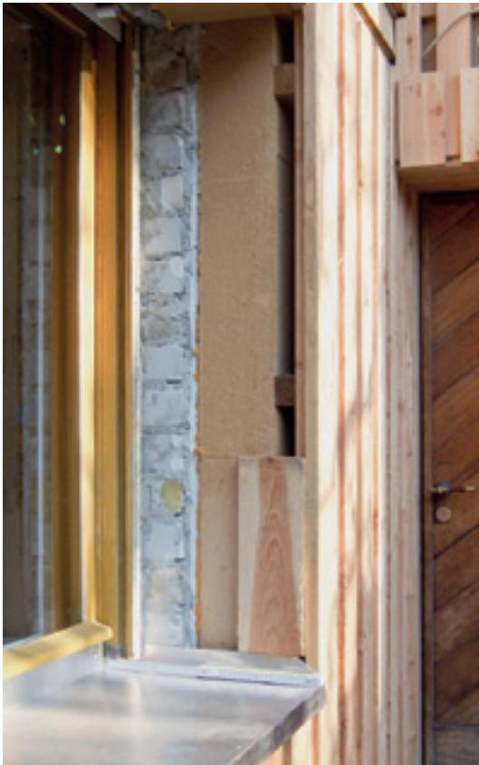
Dämmung und hinterlüftete Fassade © Klempnow
