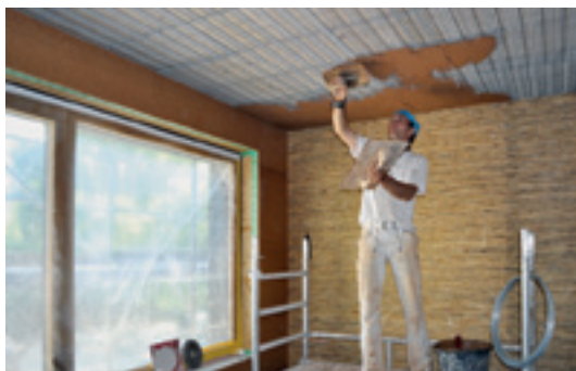
Lehmputz, Wand und Decke, Bambusmatten © Roswag Architekten
