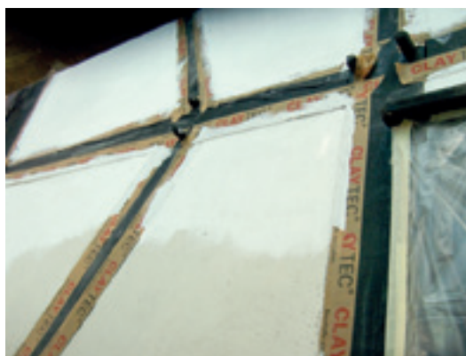
Kalkanstrich auf Lehmausfachung im Fachwerk
