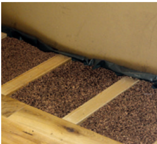
Korkschüttdämmung unter Holzfußboden © Klempnow
