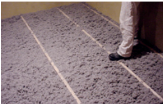
Einblasdämmung Zellulose zwischen Lagerhölzern im Fußboden © Klempnow
