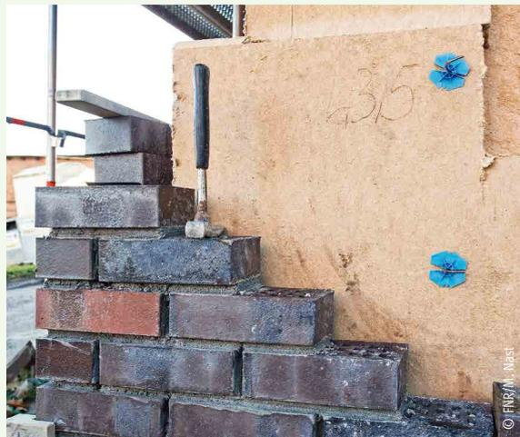
Außendämmung mit Holzweichfaserplatten hinter der Klinkervormauerung
