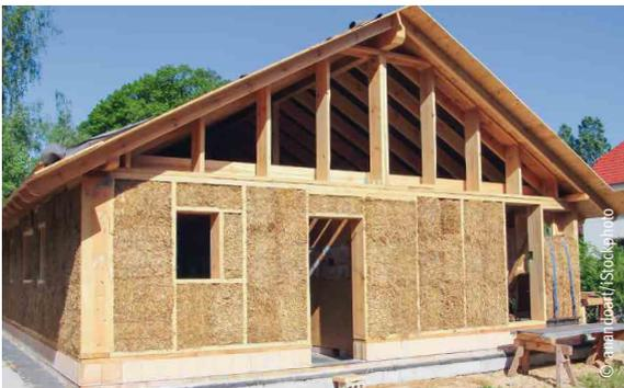
*Stroh in Form von Kleinballen ist ein hervorragender Dämmstoff.*
