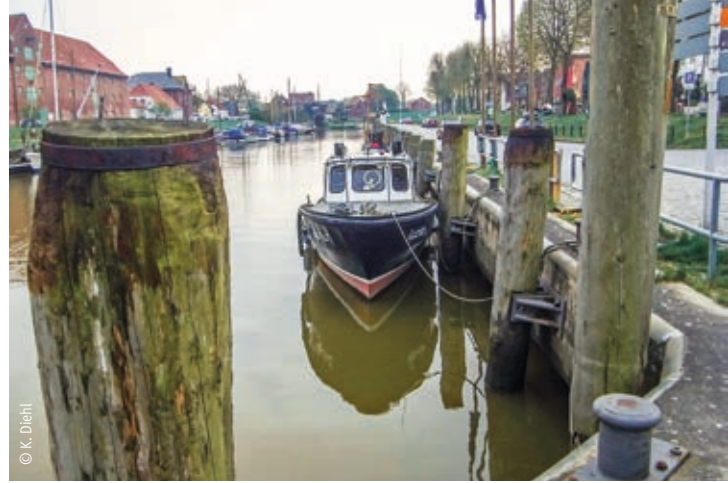
Holz-Dalben in einem Hafen: Gebrauchsklasse 5
