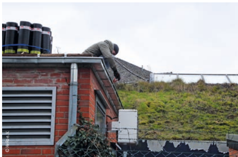
Aufbringen von Dachbitumenbahnen
